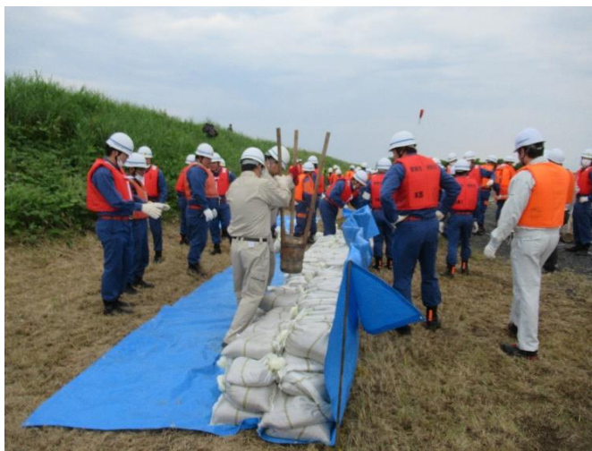
各自治体の消防団による水防工法訓練 (釜段工1)
