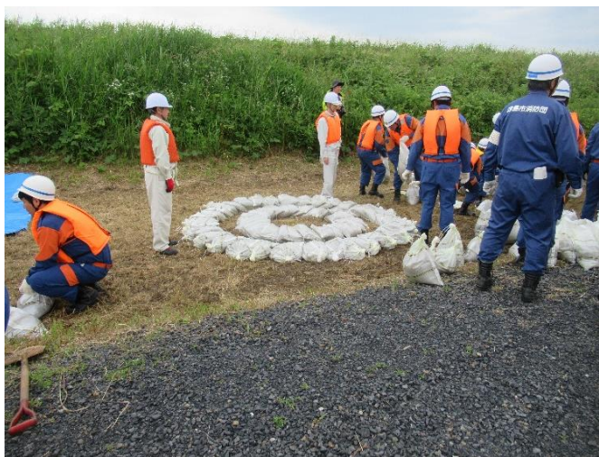
各自治体の消防団による水防工法訓練 (釜段工1)
